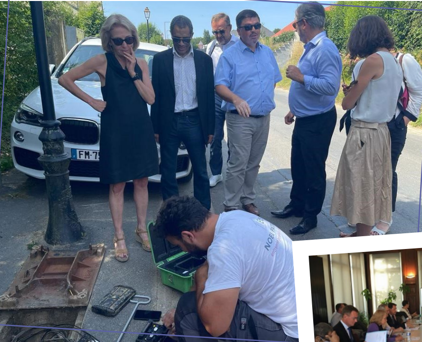
↑ Visite terrain autour d'infrastructures accueillant le réseau cuivre, ici une chambre.
