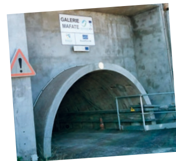
→ Entrée de la galerie du cirque de Mafate à La Réunion qui est utilisée pour le déploiement de la fibre.
