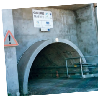
→ Entrée de la galerie du cirque de Mafate à La Réunion qui est utilisée pour le déploiement de la fibre.
