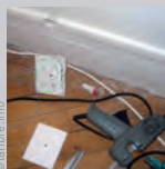
Pose de la fibre dans l'appartement
