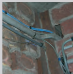
La fibre remonte au niveau de la cave dans la cage d'escalier
