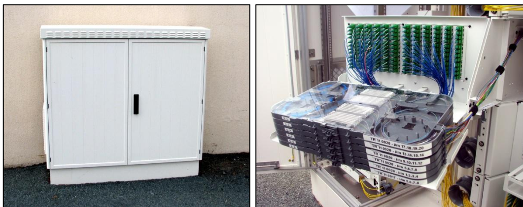
Figure 9 : Exemple de PM en armoire de rue (à gauche) avec tiroir et cassettes de distribution (à droite)
