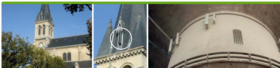
Antennes mobiles intégrées sur le toit d'une église et sur les flancs d'un château d'eau
