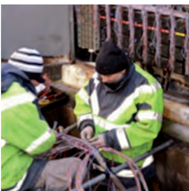
Dérivation de la boucle locale de cuivre au niveau du sous-répartiteur dans le cadre d'une opération de montée en débit
