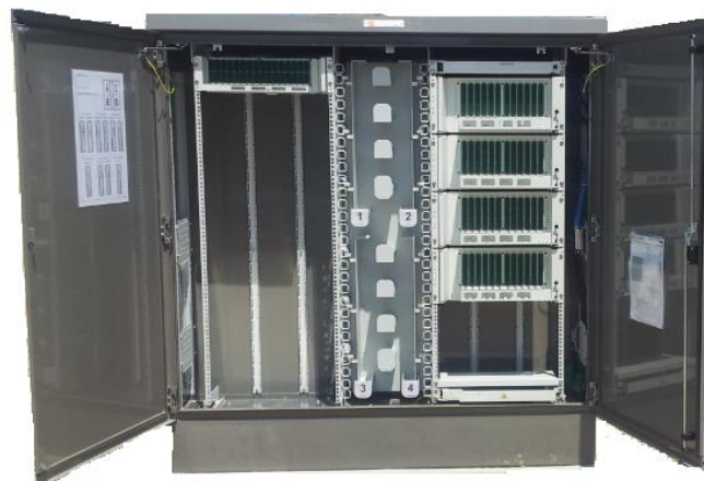
Exemple d'un PM, 360 locaux desservis, 576 fibres distribuées
